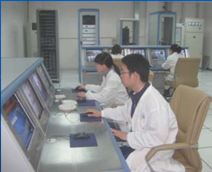
中心控制机房
